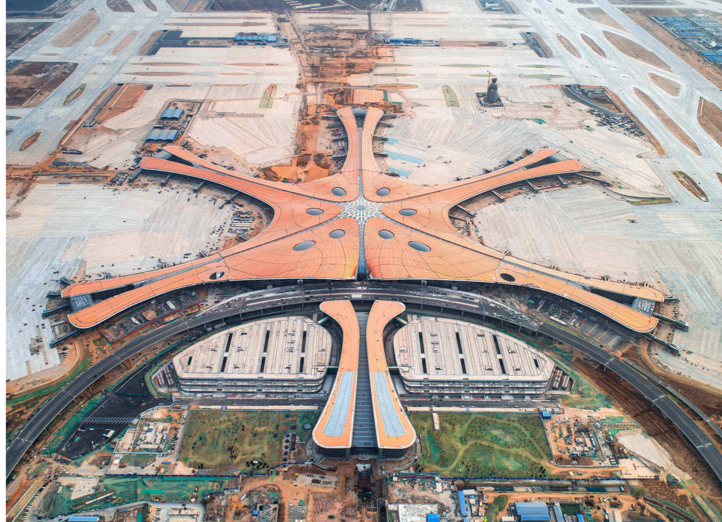
为大兴机场科学管控施工进度保障施工进展
