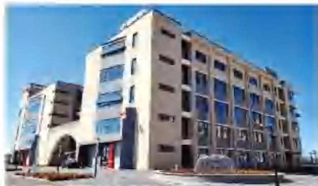
材料化学专业实验教学大楼
